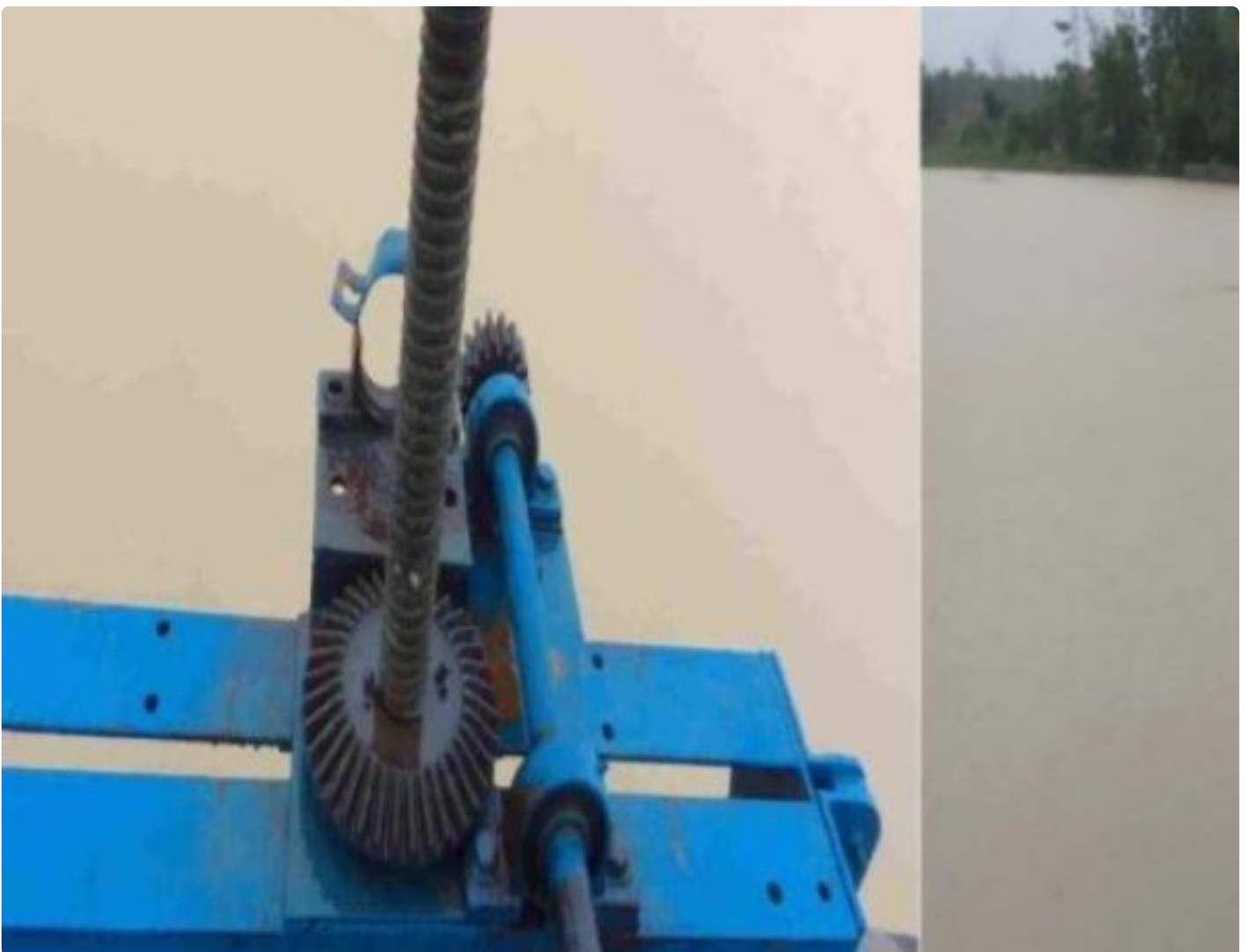
Pintu air Albaret Simpang Mesuji
